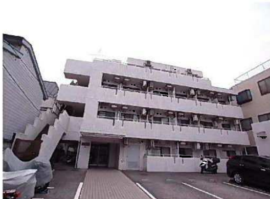
外観タイル貼り
