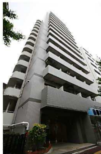
外観 タイル貼り
