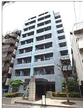
外観タイル貼り
