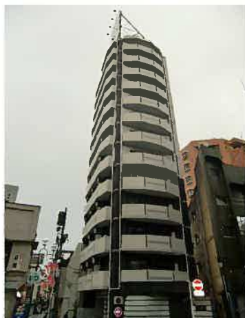
外観タイル貼り
