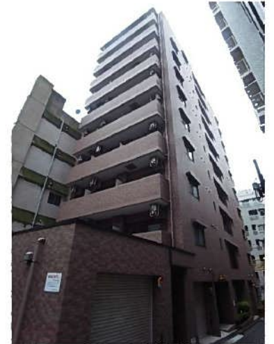
外観タイル貼り
