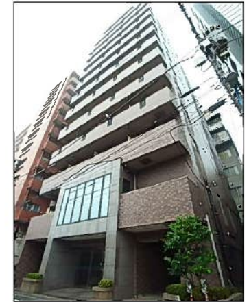
外観タイル貼り
