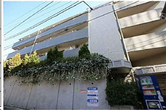
外観タイル貼り
